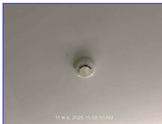
รูปที่ 2.20 อุปกรณ์ตรวจจับควัน
