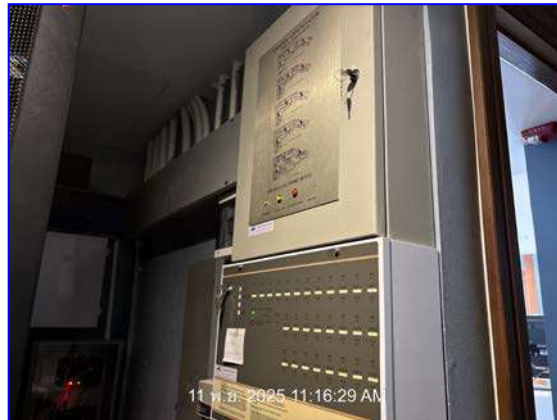
รูปที่ 2.25 แผงควบคุมระบบสัญญาณแจ้งเหตุเพลิงไหม้
